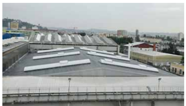
Neue Dachansicht vom Objekt 211
